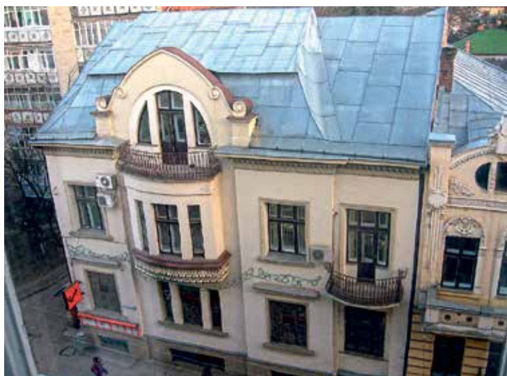
BUDYNEK PRZY UL. CZORNOWOŁA 23
