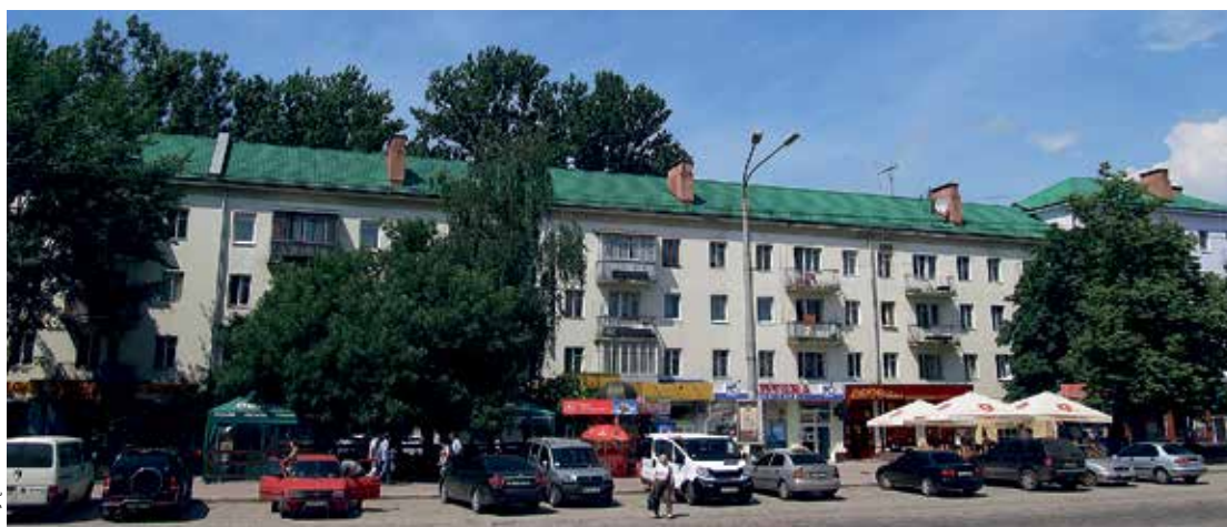
FASADA BUDYNKU NA PLACU PRZED DWORCEM
